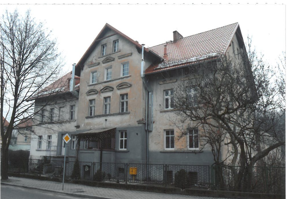
WIDOK OD STRONY ZACHODNIEJ.
