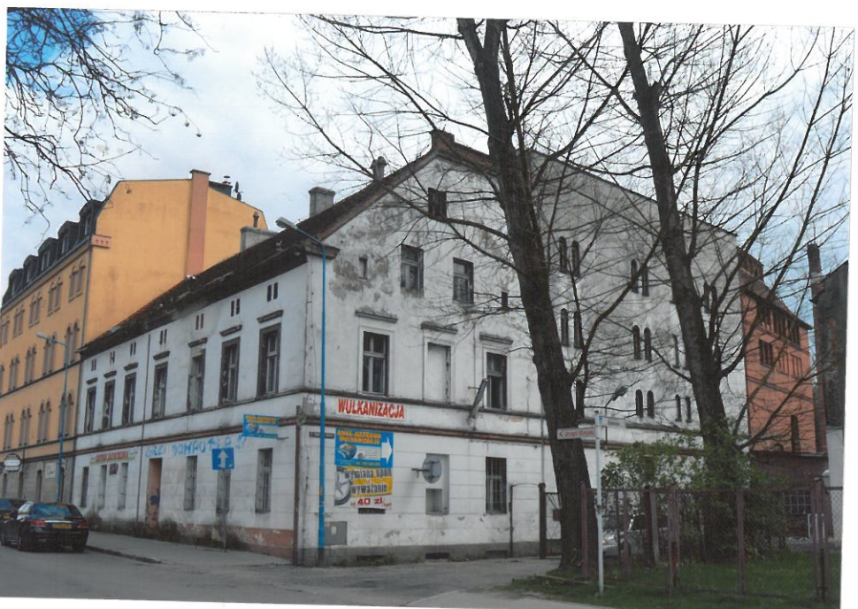
WIDOK OD STRONY PÓŁNOCNO-WSCHODNIEJ.
