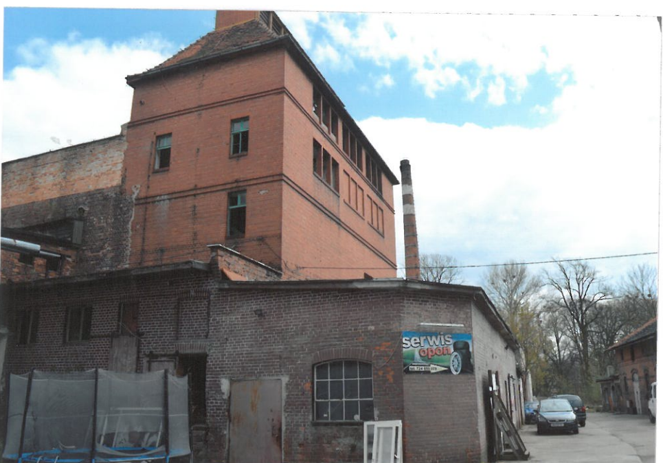
WIDOK OD STRONY PÓŁNOCNO-ZACHODNIEJ.
