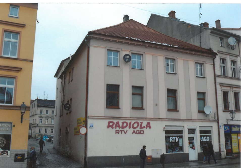
WIDOK OD STRONY POŁUDNIOWO-ZACHODNIEJ.
