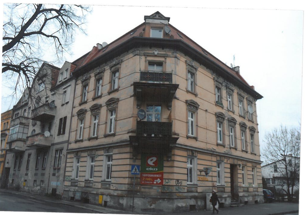
WIDOK OD STRONY POŁUDNIOWO-ZACHODNIEJ.
