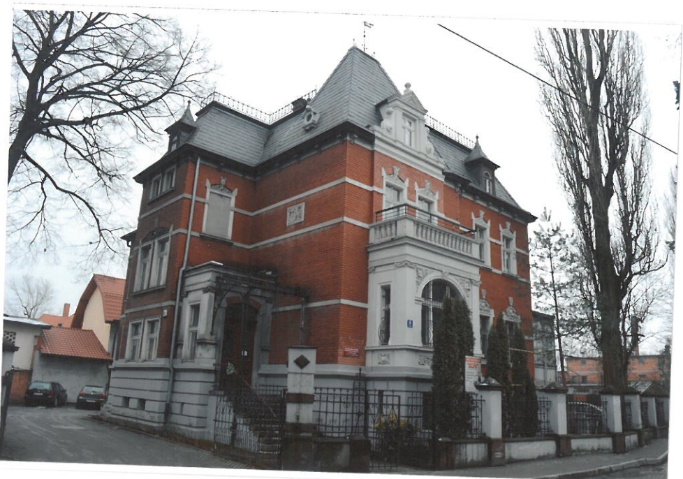
WIDOK OD STRONY ZACHODNIEJ.
