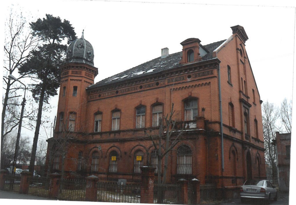
WIDOK OD STRONY PÓŁNOCNO-ZACHODNIEJ.
