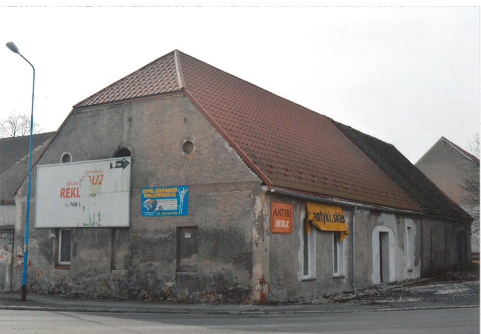
WIDOK OD STRONY PÓŁNOCNO-WSCHODNIEJ.
