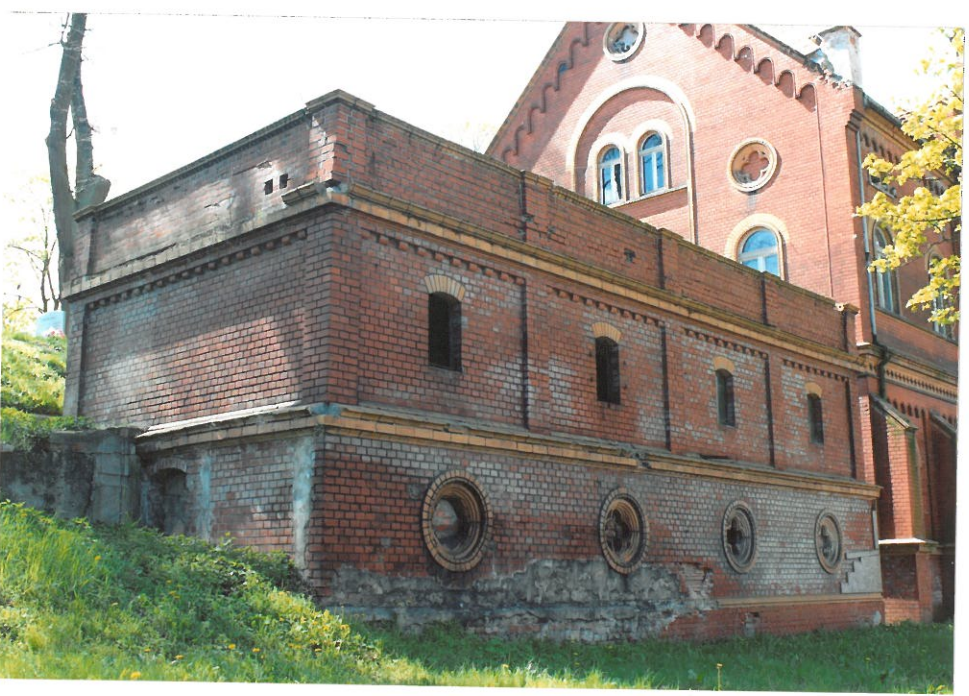
WIDOK OD STRONY POŁUDNIOWEJ.
