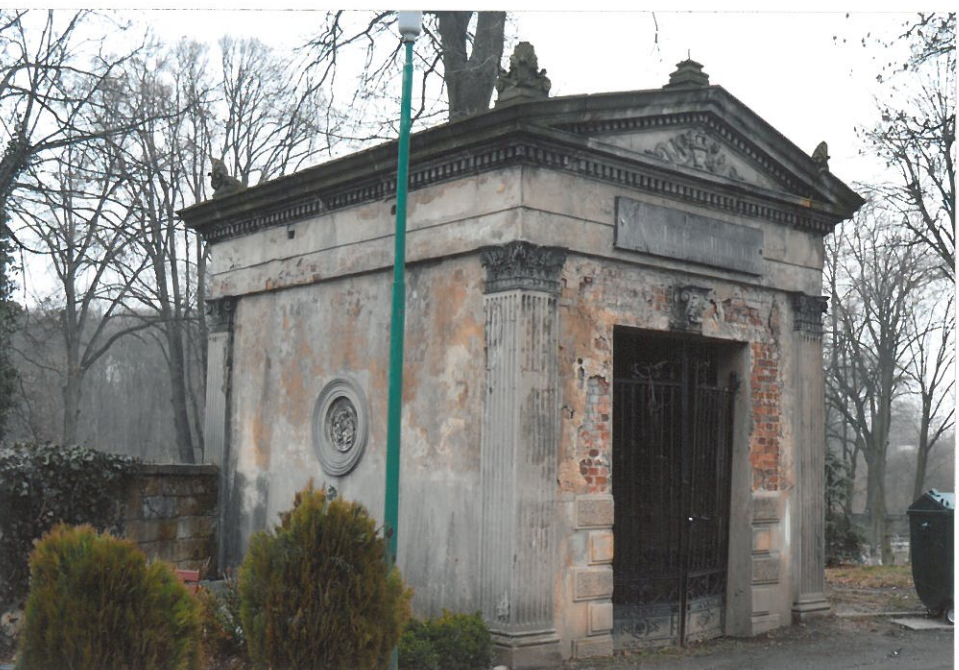
WIDOK OD STRONY POŁUDNIOWO-ZACHODNIEJ.
